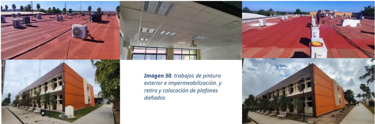
*Imagen 50. trabajos de pintura exterior e impermeabilización, y retiro y colocación de plafones dañados*
